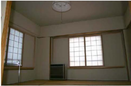
施工後の写真
